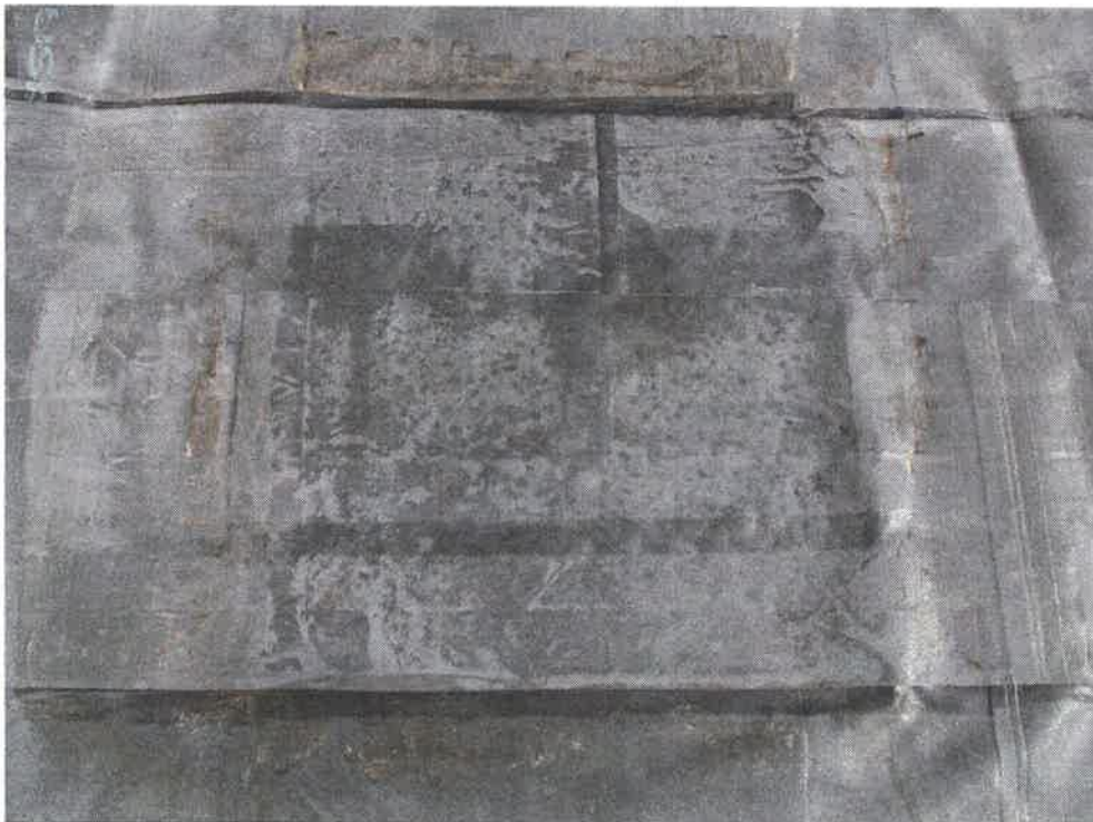
Abb. 2: Abdichtungsunterseite ohne Durchwurzlungen.
